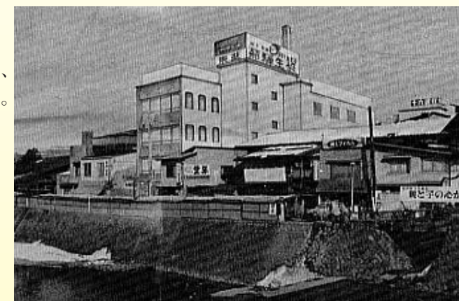
完成当時の飛騨生協会館(1970年)
