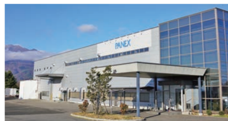
パネックス長野工場(長野県伊那市)
