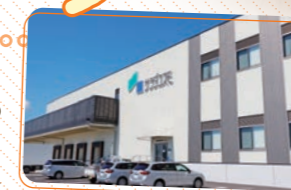
株式会社サラダコスモ 養老生産センター 岐阜県養老郡養老町大跡
