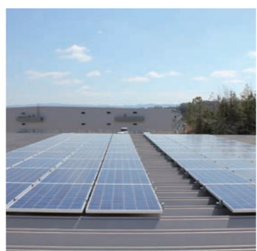
コープぎふエネルギー対策の取り組み 多治見支所、岐阜西支所、関市倉知に太陽光パネルを設置しています
