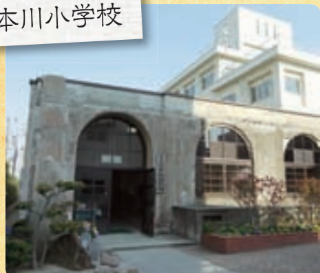
原爆の爆風に耐えた本川小学区の外壁。当時では珍しい鉄筋コンクリートの建物でした。
